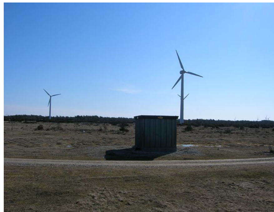
En transformatorstation på Näsudden på Gotland
